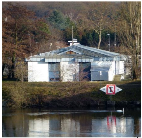
Rheinüberwachungsstation Weil (RüS) 1
